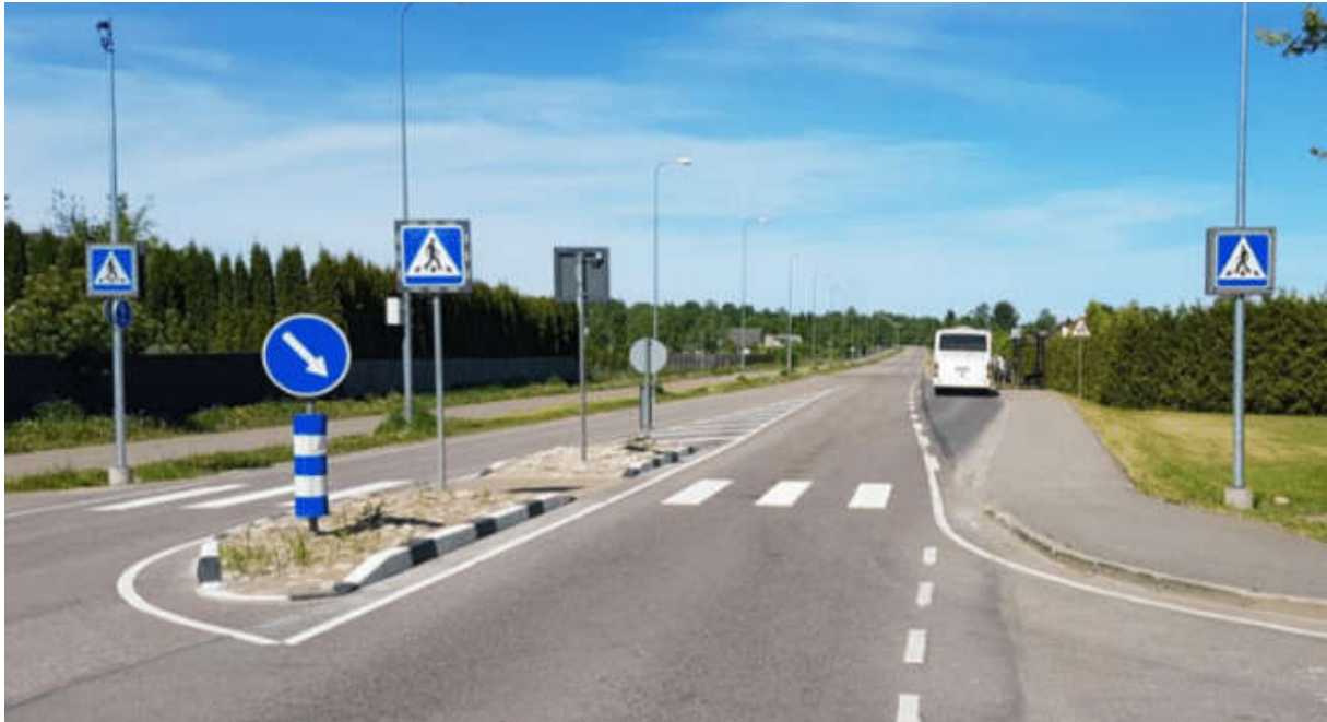
Foto 13. Randvere teel asuv hoiatuslampidega varustatud ülekäigurada (Allikas: uuring „Hoiatuslampide süsteemiga varustatud ülekäiguraja liikluskäitumusliku mõju uuring“)
