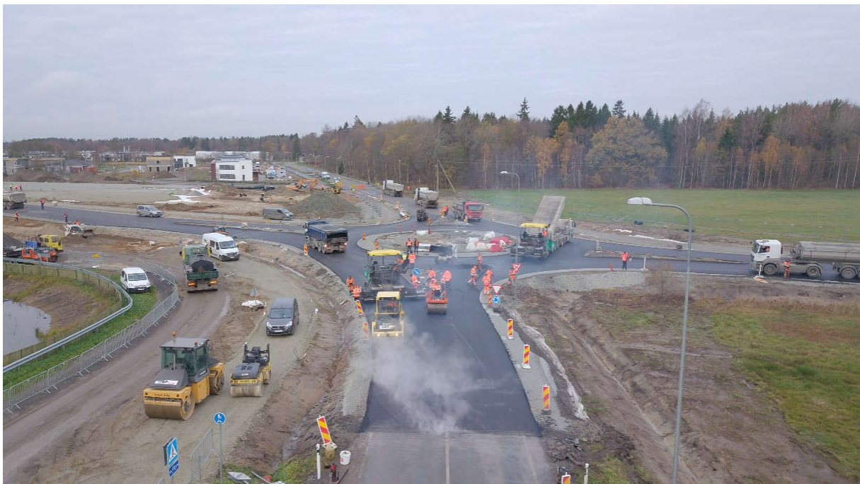
Foto 1. Lubja-Randvere ringtee asfalteerimine (Viimsi Vallavalitsuse fotokogu)
