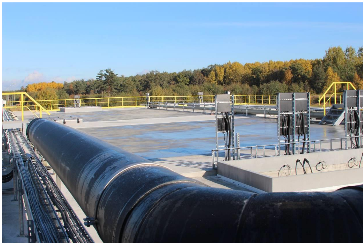
Foto 6.2 Muuga reoveepuhasti protsessimahutid (kinnised, ventileeritud)
