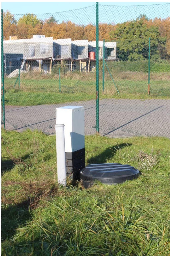
Foto 6.1 Tüüpiline kanalisatsioonipumpla välisvaade
