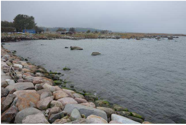
Foto 2.3. Vaade põhjamuulilt loodesse (26.09.2017).
