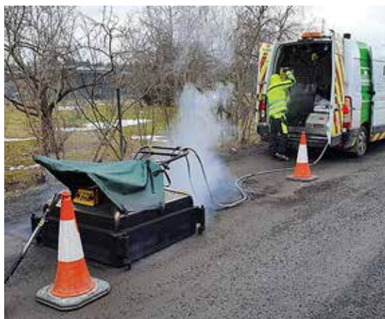
Aukude parandamine kuumkatlaga. Foto: Kalev Eensaar
