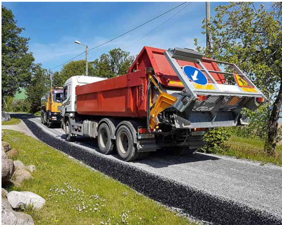
Ühekordse pindamise käigus laotatakse teekatteks üks bituumeni ja seejärel üks graniitkillustiku kiht, kahekordse pindamise korral laotatakse veel teine bituumensideaine kiht, mis kaetakse graniitkillustiku kihiga. Foto: Alar Mik
