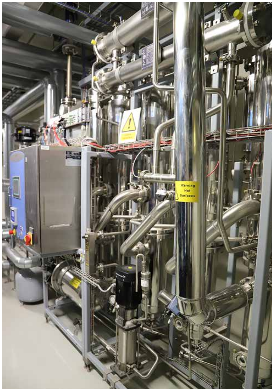
Seadmed, millega puhastatakse vett ligi 2000 korda puhtamaks, kui joogiveele kehtivad nõuded. Fotod: Martin Jaško
