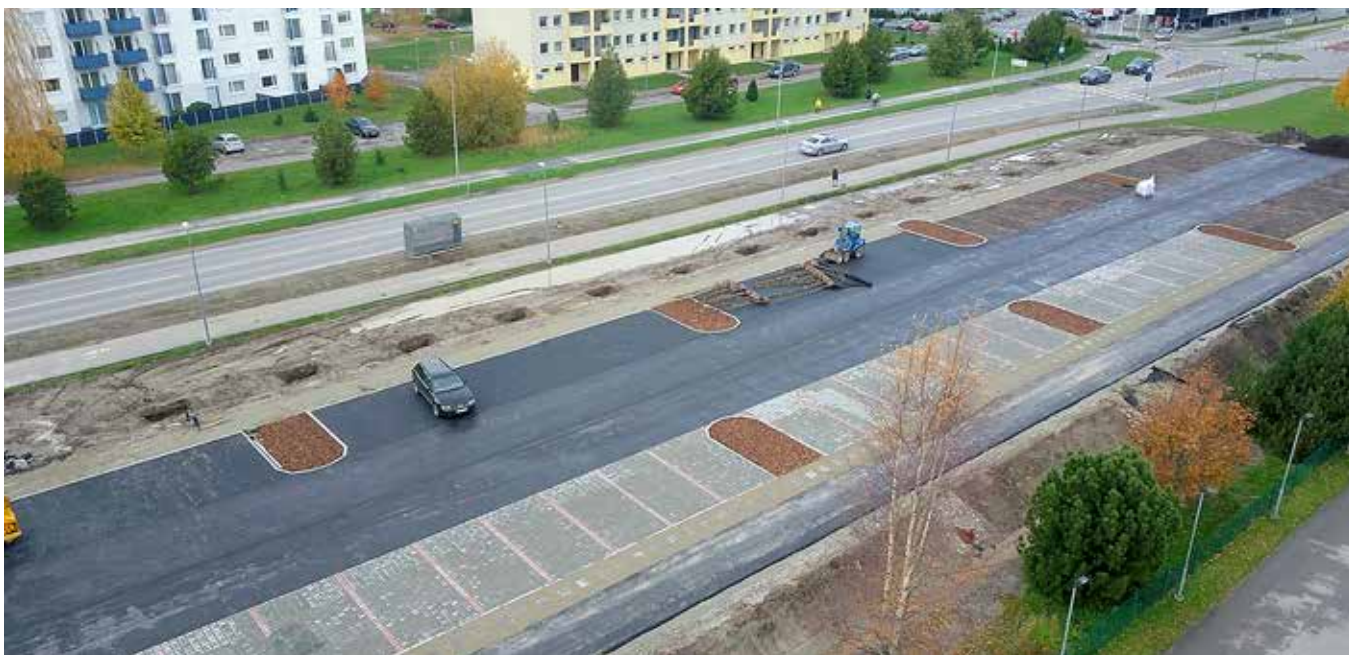
Droonivaade valminud parklale, toimuvad puude istutamise tööd. Droonifoto: Siim Reinla
