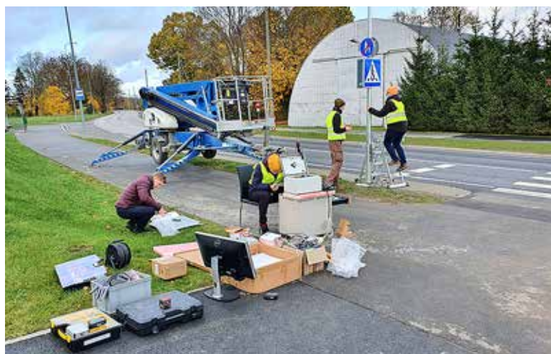
Ülekäiguraja märkide ja seadmete paigaldamine – töö käib postil ja arvutis. Foto: Alar Mik
