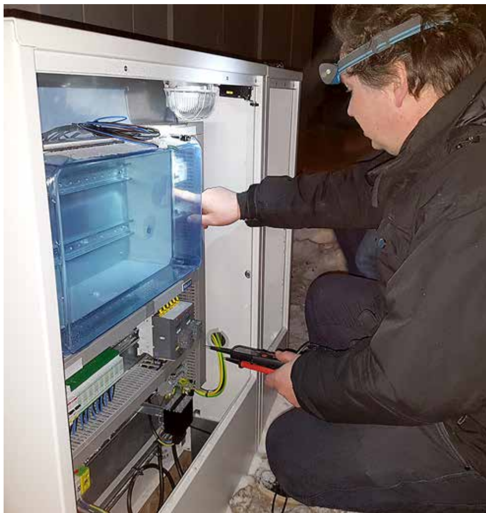
Käidumeister Tõnu Roosna testperioodil juhtimiskilbis keset ööd riket tuvastamas.
