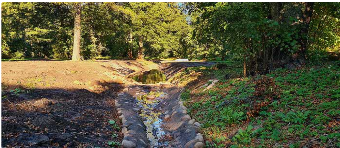
Sademevee lahendus Viimsi mõisa pargis. Foto: Taavi Valgmäe
