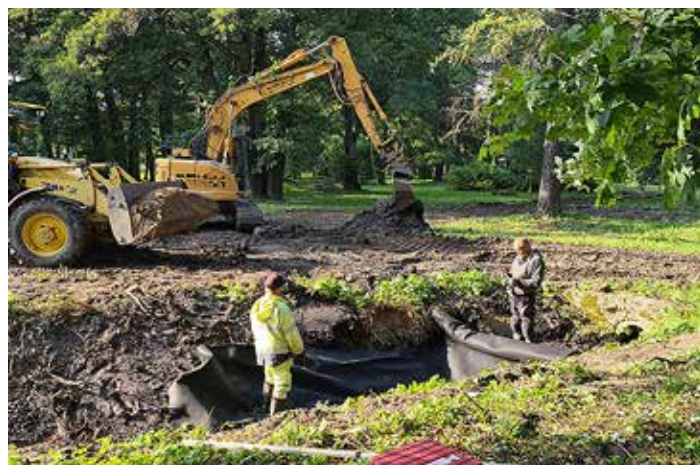
Kraavide setetest süvendamine ja kanga paigaldus. Foto: Taavi Valgmäe
