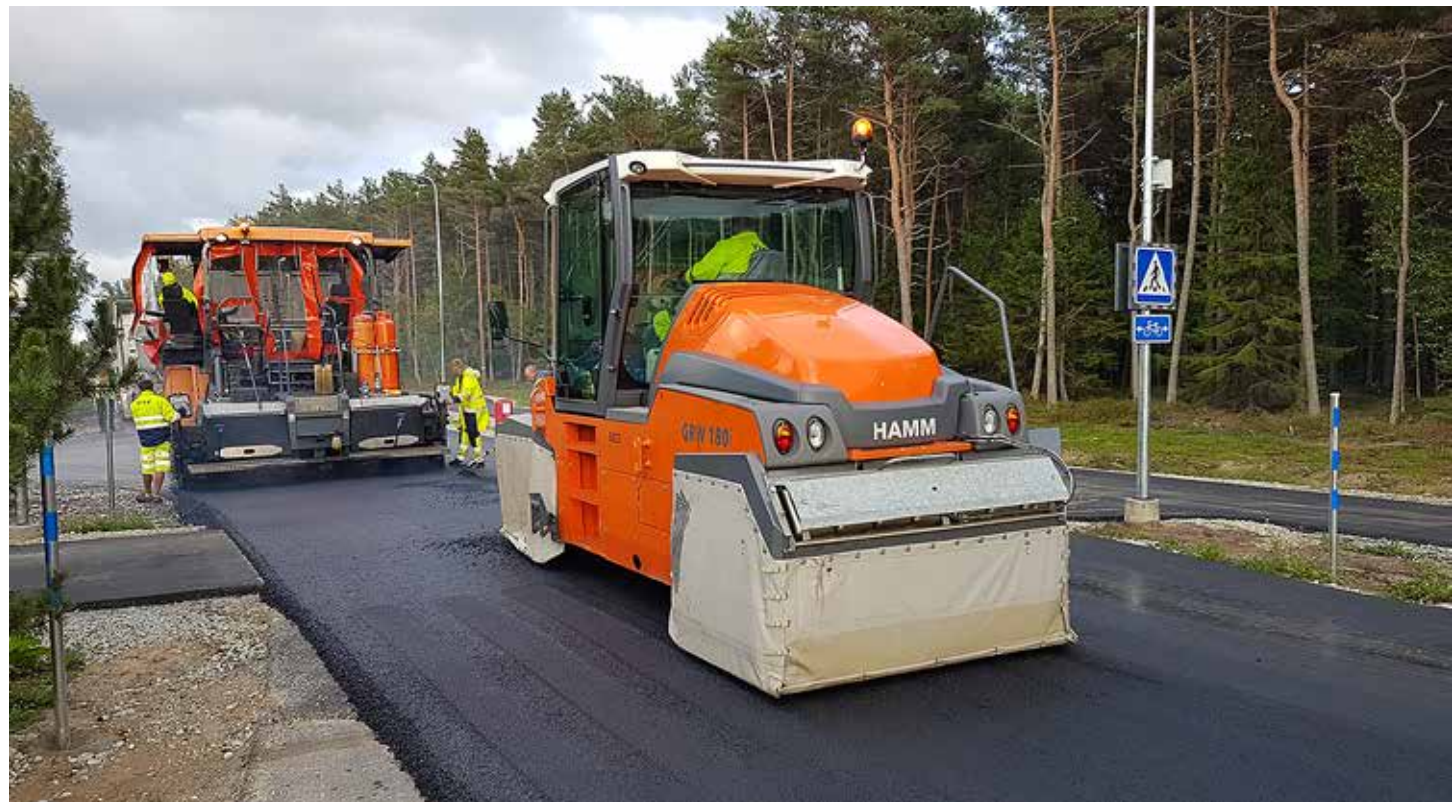
Reinu tee rekonstrueerimisel paigaldati 3,65 ha asfaltkatet. Foto: Alar Mikk
