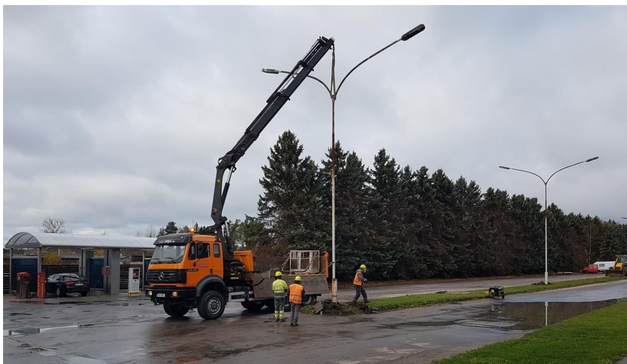
Foto 6. 1970ndatel aastatel Sõpruse tee rajatud valgustusmastide eemaldamine 2018 aastal
