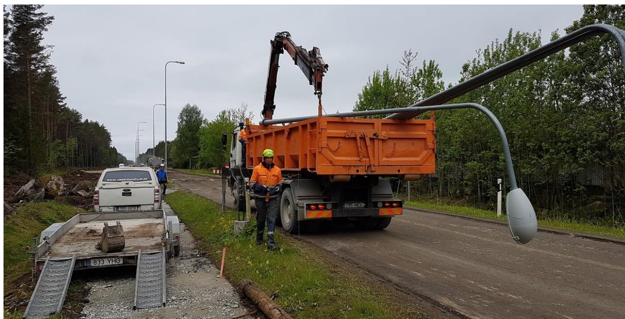
Foto 2. Vanade naatriumvalgustite demonteerimine Reinu teel 2019 aastal
