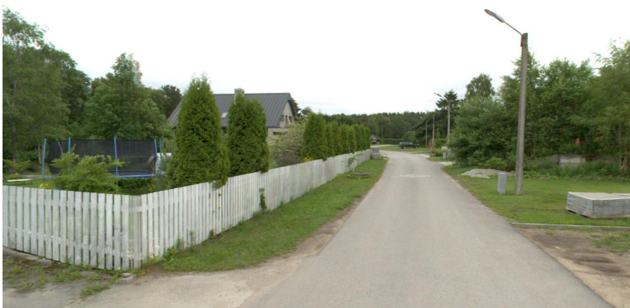
Foto 13. Äigrumäe amortiseerunud valgustus raudbetoonmastidel (Foto StreetU)
