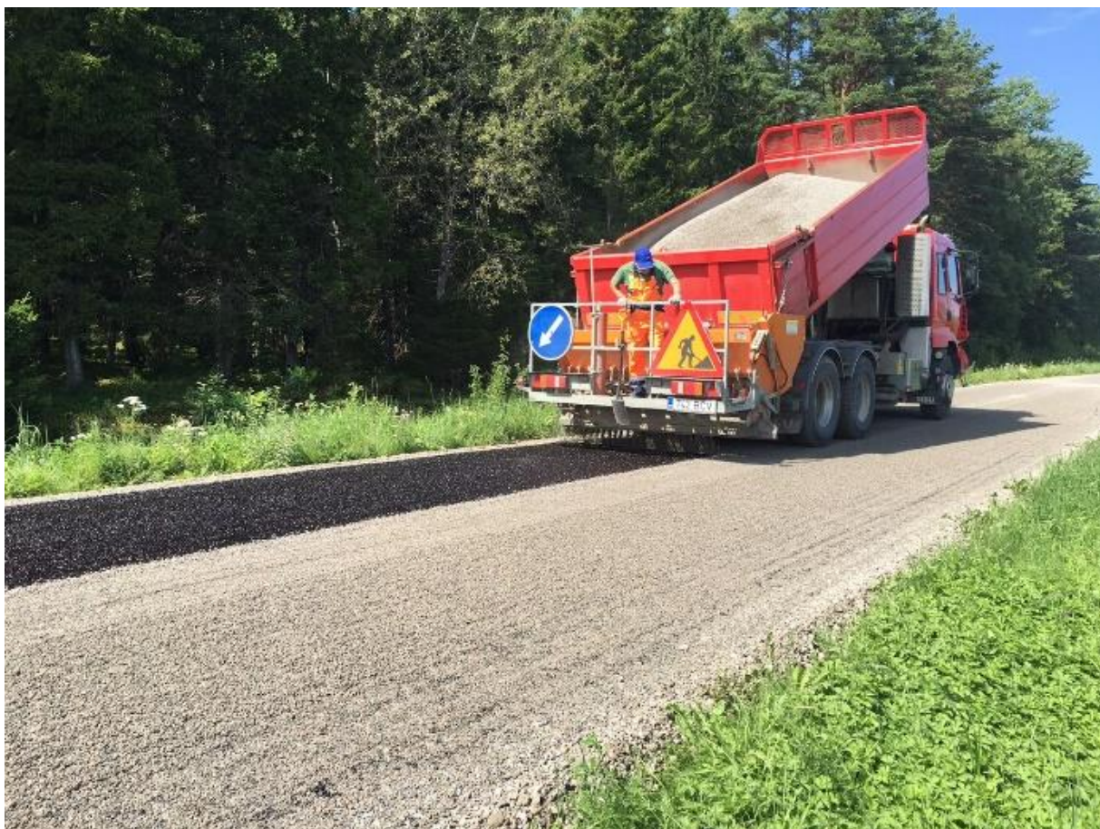
Foto 43. Säilitusremont, pindamistööd Ristika teel (Viimsi Vallavalitsuse fotokogu)
