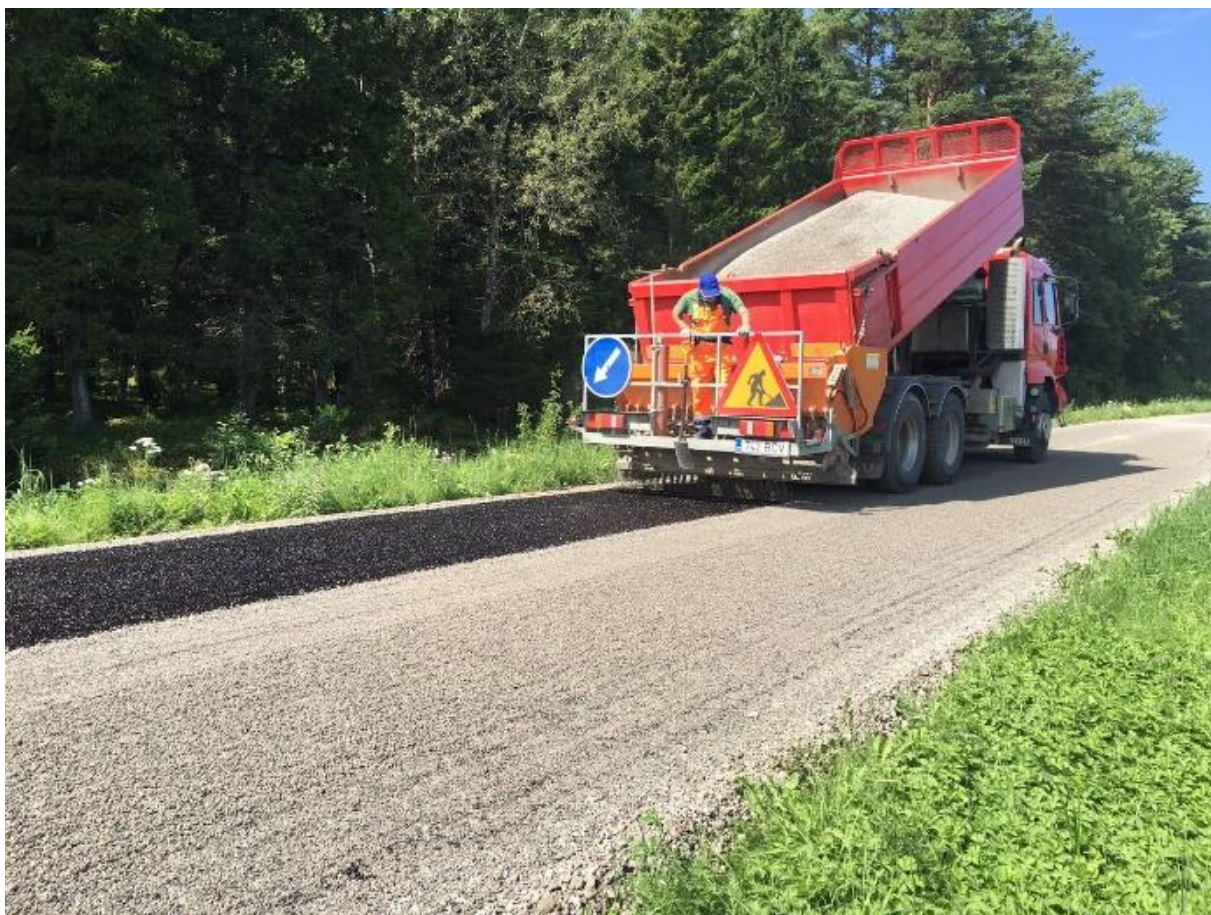
Foto 43. Säilitusremont, pindamistööd Ristika teel (Viimsi Vallavalitsuse fotokogu)
