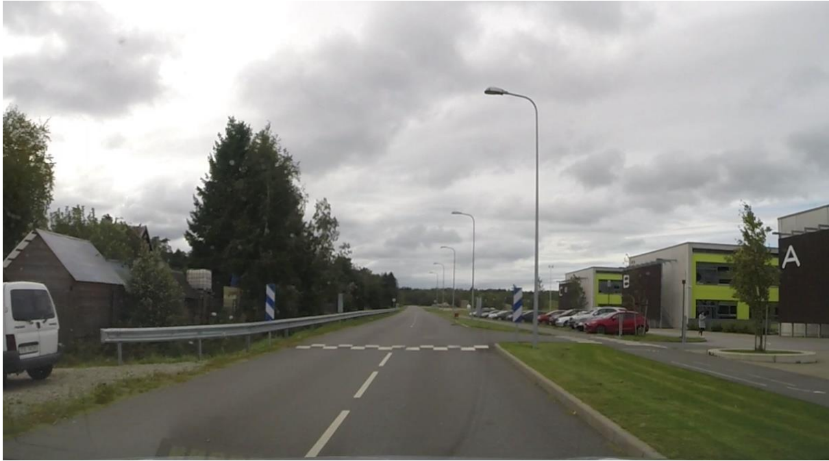
Foto 25. Liikluse rahustamiseks tõstetud teekate G.H.Schüdlöffeli teel
