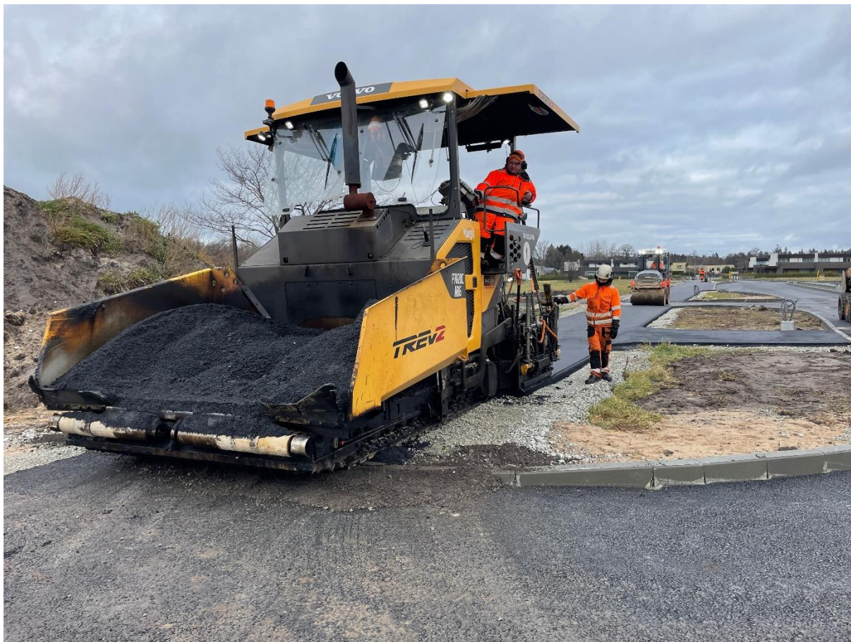
Foto 8. Põldheina tee kergliiklustee asfalteerimistööd (Viimsi Vallavalitsuse fotokogu)
