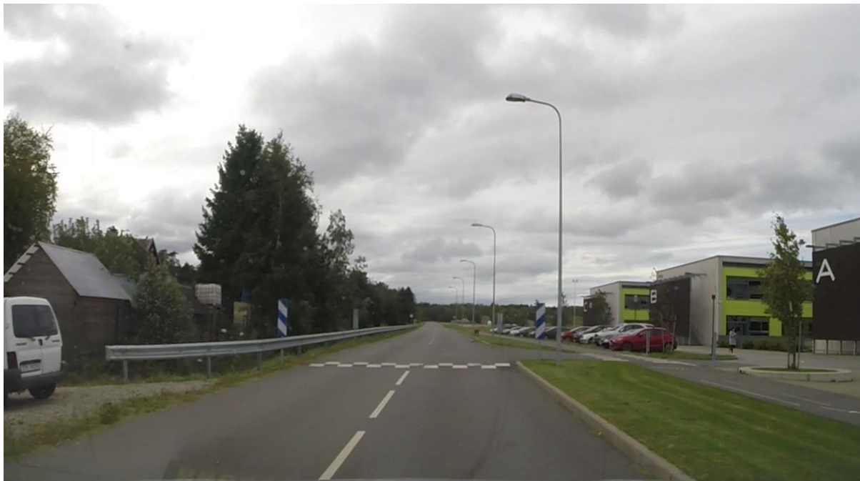
Foto 25. Liikluse rahustamiseks tõstetud teekate G.H.Schüdlöffeli teel
