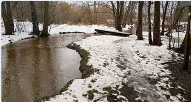
Ilmastikuoludest tingitud üleujutuste ennetamiseks on oluline kraavide ja truupide korrashoid. Foto: ehitus- ja kommunaalosakond
