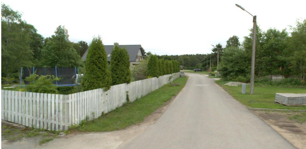
Foto 13. Äigrumäe amortiseerunud valgustus raudbetoonmastidel (Foto StreetU)
