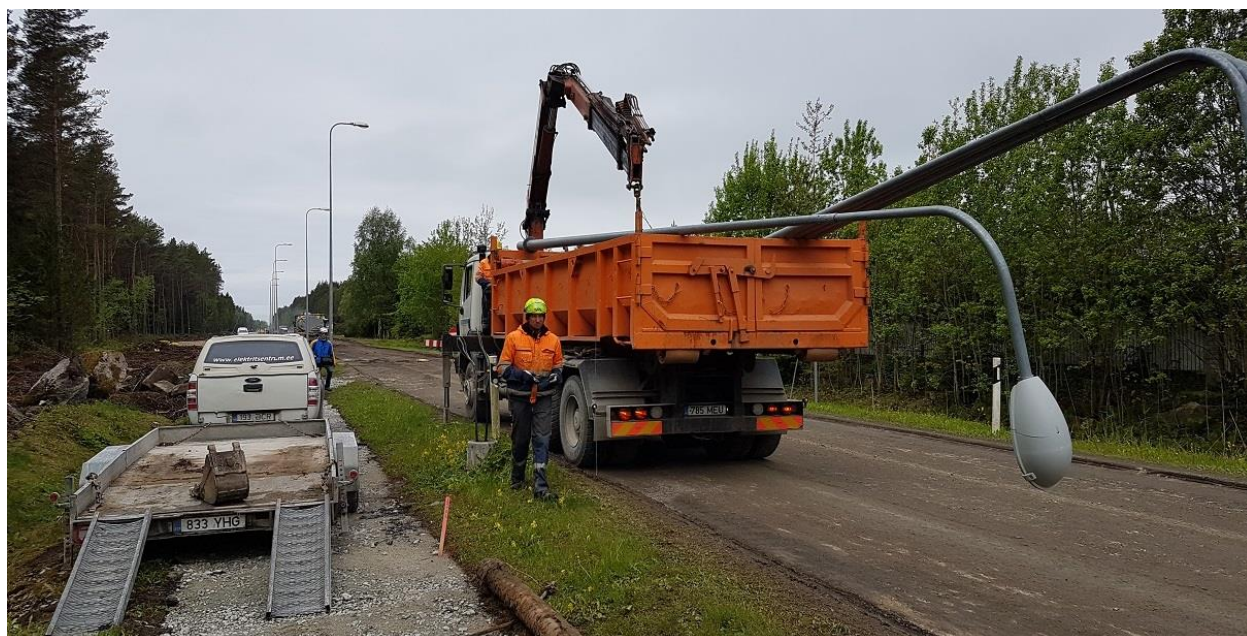
Foto 2. Vanade naatriumvalgustite demonteerimine Reinu teel 2019 aastal
