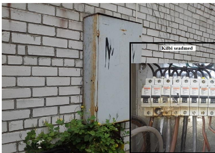
Foto 9. Näide amortiseerunud ja keskkonnaoludele mittevastavast tänavavalgustuskilbist
