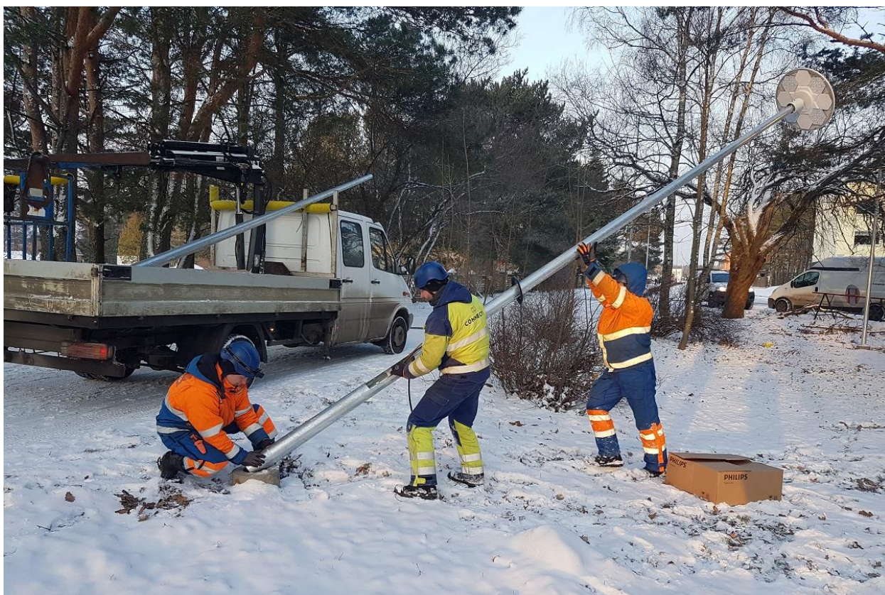
Foto 19. Uute LED valgustite panek Haabneemes amortiseerunud valgustite asemele 2019 talvel
