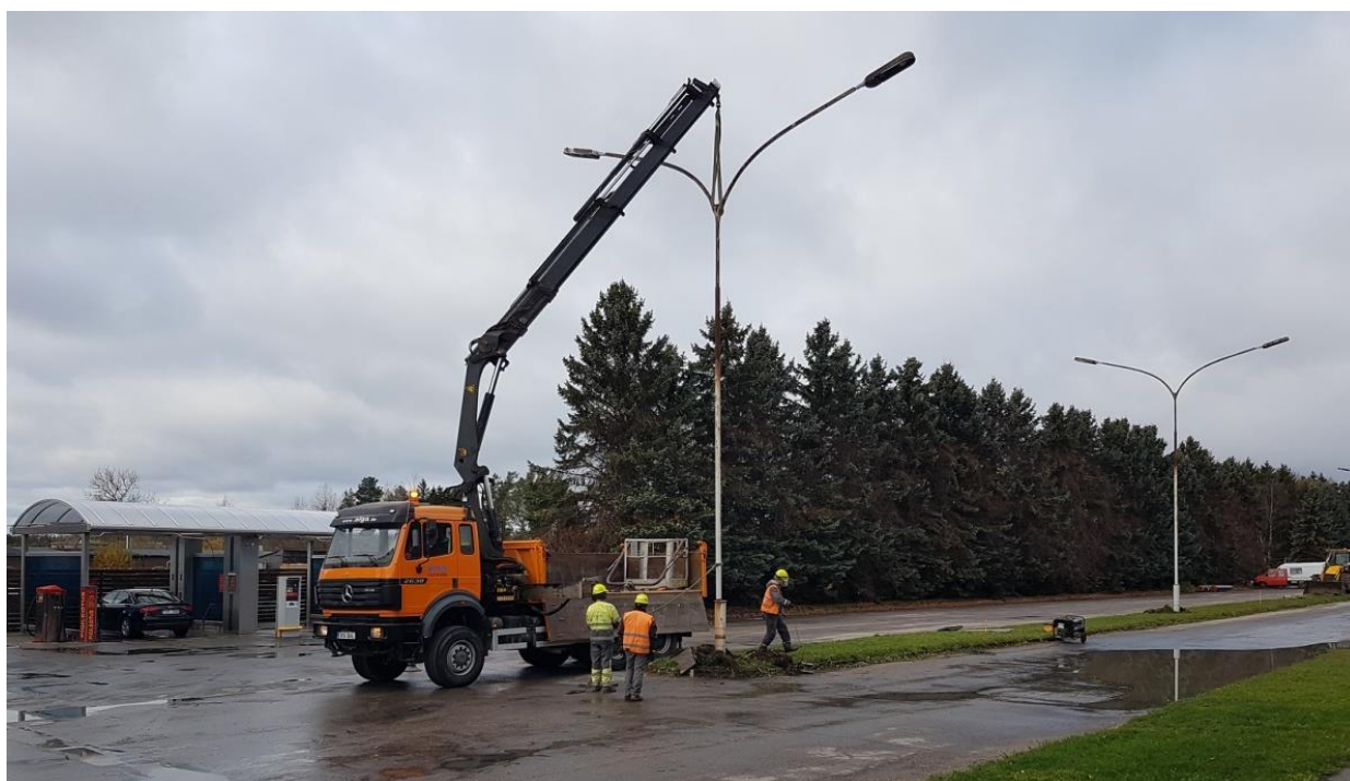
Foto 6. 1970ndatel aastatel Sõpruse teele rajatud valgustusmastide eemaldamine 2018 aastal
