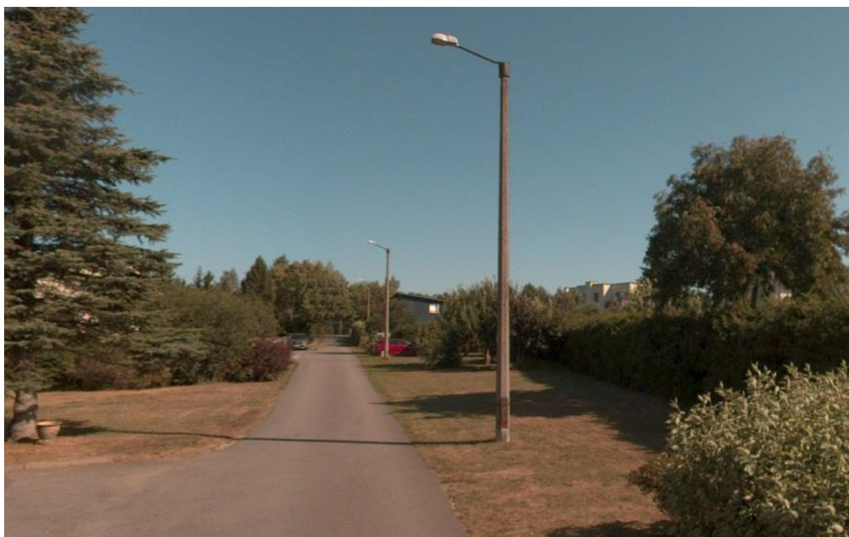
Foto 8. Vaade Priimula teel asuvatele raudbetoonist amortiseerunud mastidele, mis renoveeritakse Viimsi valla LED II projekti raames
