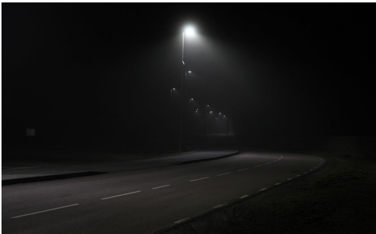
Foto 7. Leppneeme teel kasutatav radarjuhtimissüsteem loob täiendavat säästu. Esiplaanil valgustid 80% võimsusega töötamas, tagaplaanil 20% võimsus (kui liiklejad ei ole)
