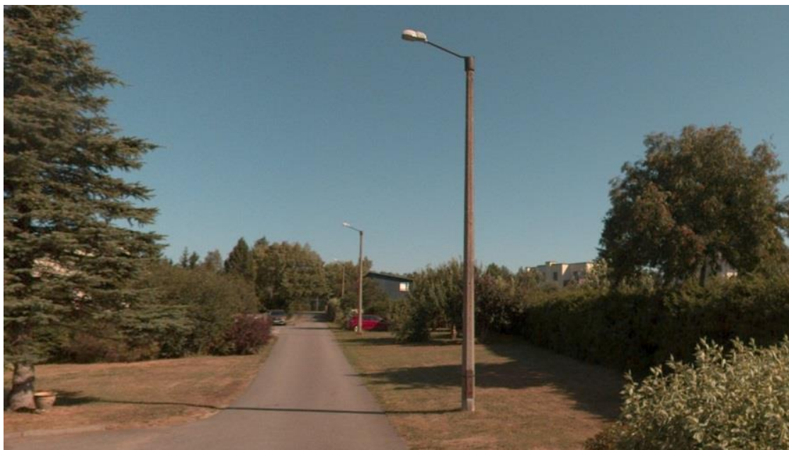
Foto 10. Vaade Priimula teel asuvatele raudbetoonist amortiseerunud mastidele, mis renoveeriti Viimsi valla LED II projekti raames
