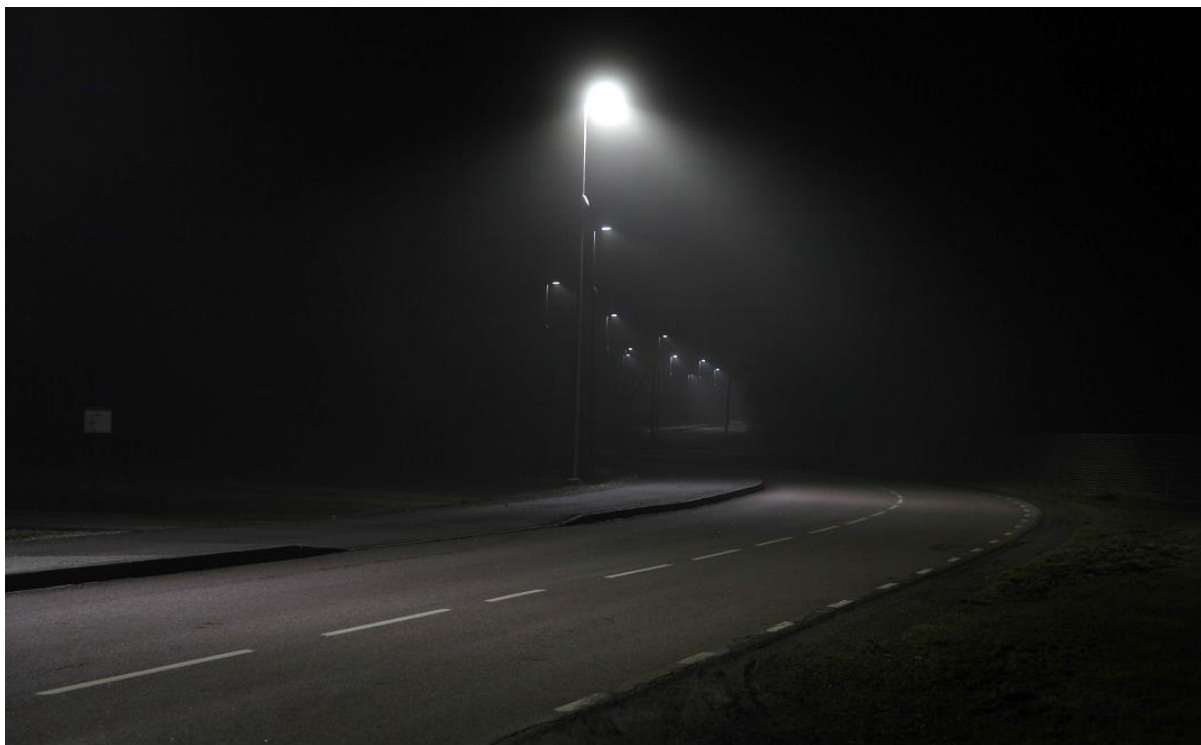
Foto 8. Leppneeme teel kasutatav radarjuhtimissüsteem loob täiendavat säästu. Esiplaanil valgustid 80% võimsusega töötamas, tagaplaanil 20% võimsus (kui liiklejad ei ole)
