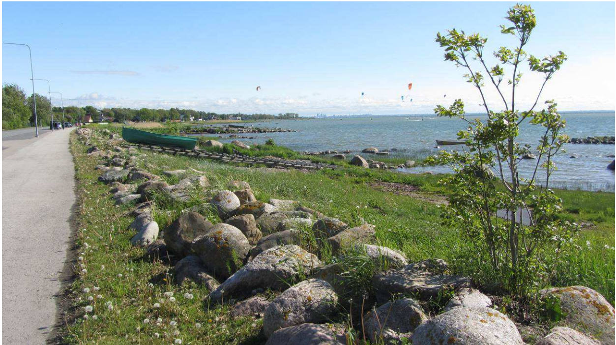
Foto 2.3. Rohuneeme tee on kindlustatud ranniku ulatuses graniitkividega, sest kõrgemate veetasemetega võivad lained murrutada teelust peent pinnast.
