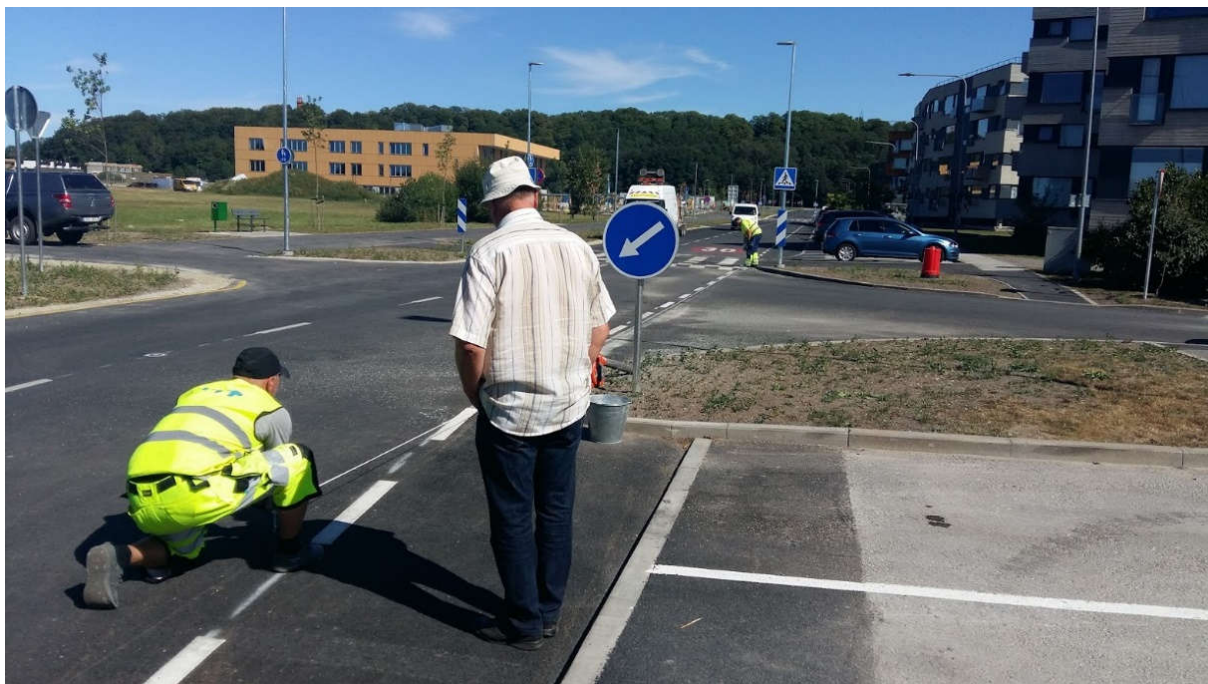
Foto 2. Tammepõllu tee markeerimine järelevalve silme all (Viimsi Vallavalitsuse fotokogu)
