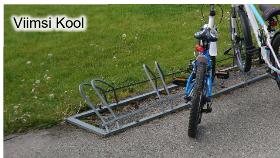
Foto 10. Näiteid deformeerunud hoidikutest
