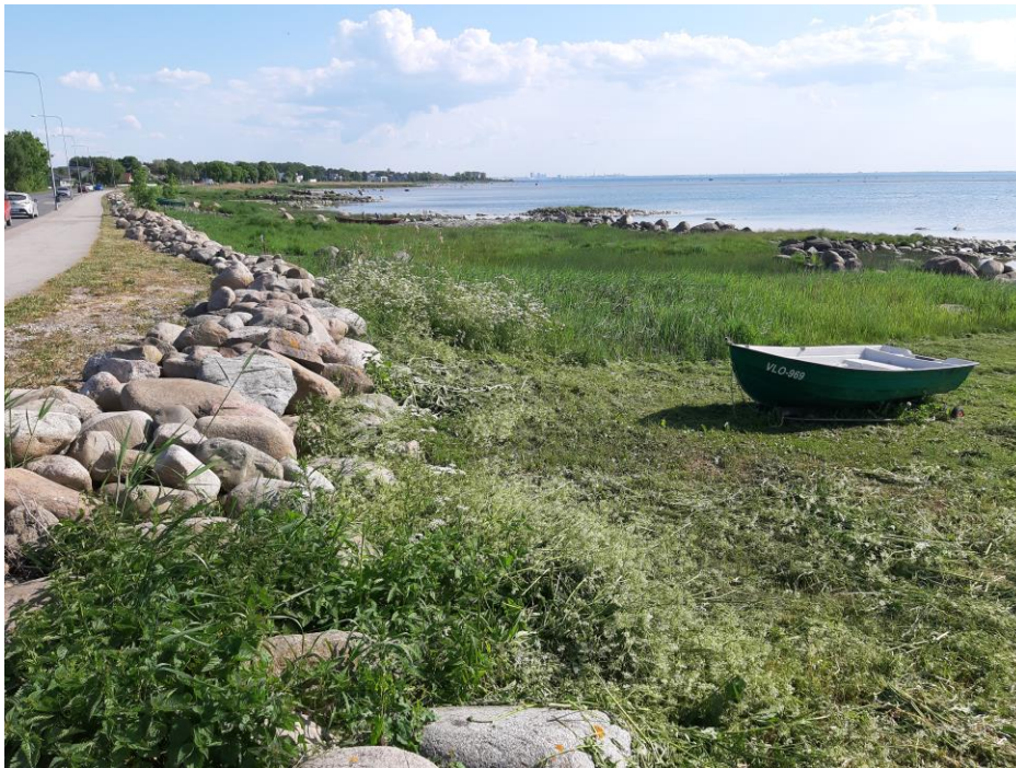
Foto 2.3. Rohuneeme tee on kindlustatud ranniku ulatuses graniitkividega, sest kõrgemate veetasemetega võivad lained murrutada teealust peent pinnast. Kohaliku kinnitusel jõuavad lained kõrge veetasemega teeni. 11.06.2021.
