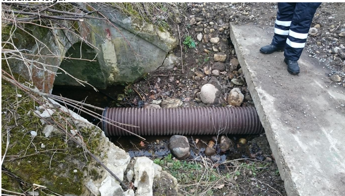
Joonis 4.42 Aladimensioneeritud sademeveesüsteem Orhidee tee ja raudtee vahelisel lõigul
