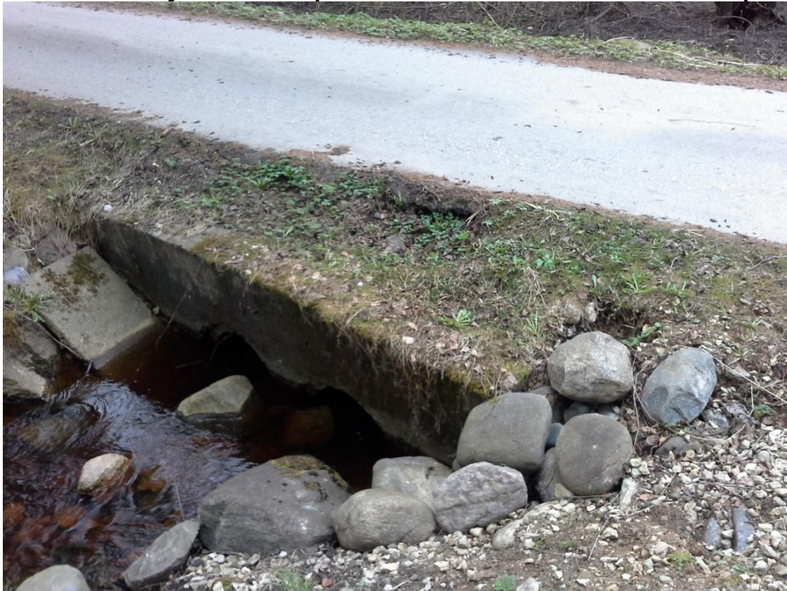
Joonis 4.39 Veejuhtme K-7.5 peal olev amortiseerunud tee-alune truup
