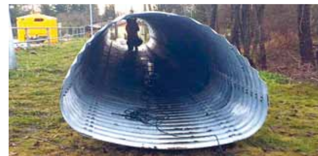
Algust on tehtud terastruubi monteerimisega. Foto Siim Jürima
