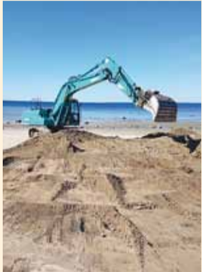
Ettevalmistustööd Haabneeme ranna muuli rekonstrueerimiseks. Foto Taavi Valgmäe
