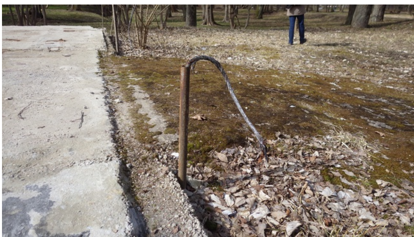
Foto 51. Pargi kagupiiril paiknev ohtlik objekt. 126
