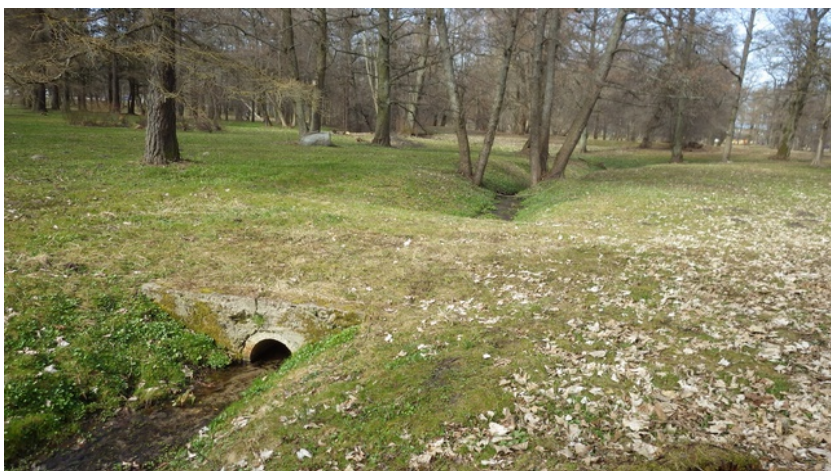
Foto 42. Ajalooline sillakoht pargi kagu osas. 115
