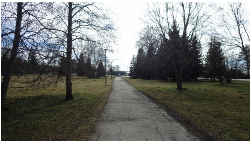
Foto 35. Pargi edelaosast kulgev asfaltkattega tee, mis vajab hooldust. 2017. 99
