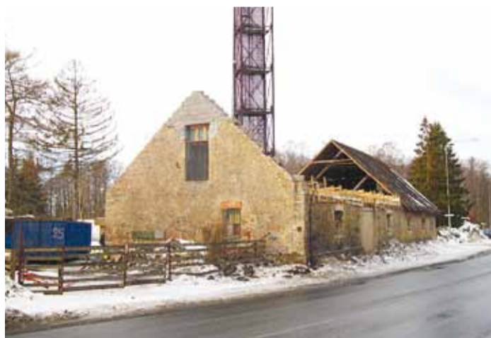
Ehitusjärgus looduskeskuse kõrvalhoone, kuhu tulevad saal, õppeklass ja metsateemaline püsiekspositsioon.
