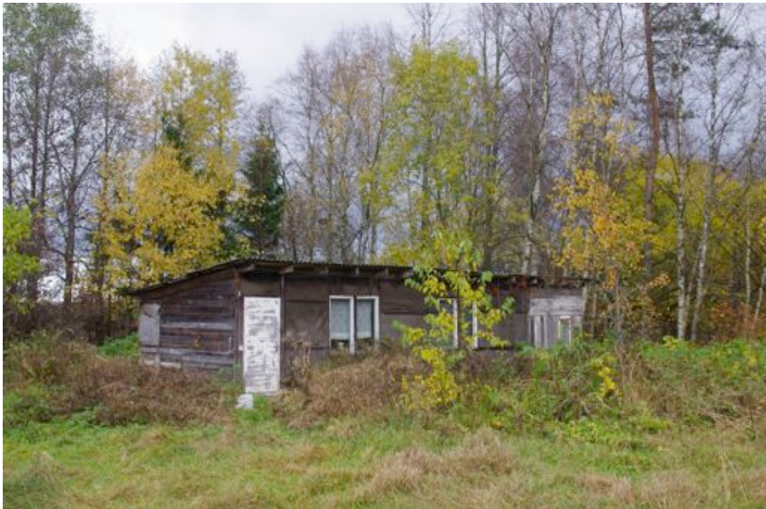
Foto 2: Vaade kinnistul olevale puitkonstruktsiooniga lagunenu suvilahoonele.
