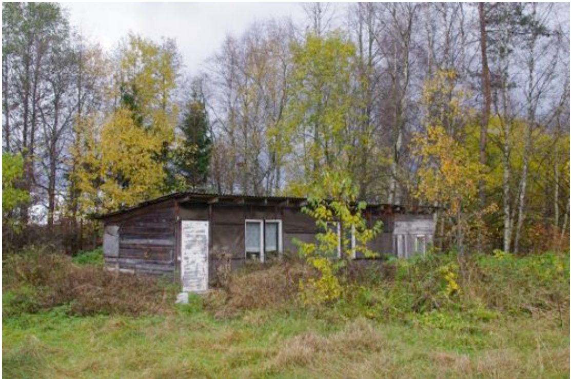
Foto 2: Vaade kinnistul olevale puitkonstruktsiooniga lagunenu suvilahoonele.
