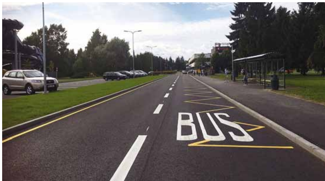
Ravi tee rekonstrueerimistööd on jõudnud lõpuni. Foto Kommunaalamet
